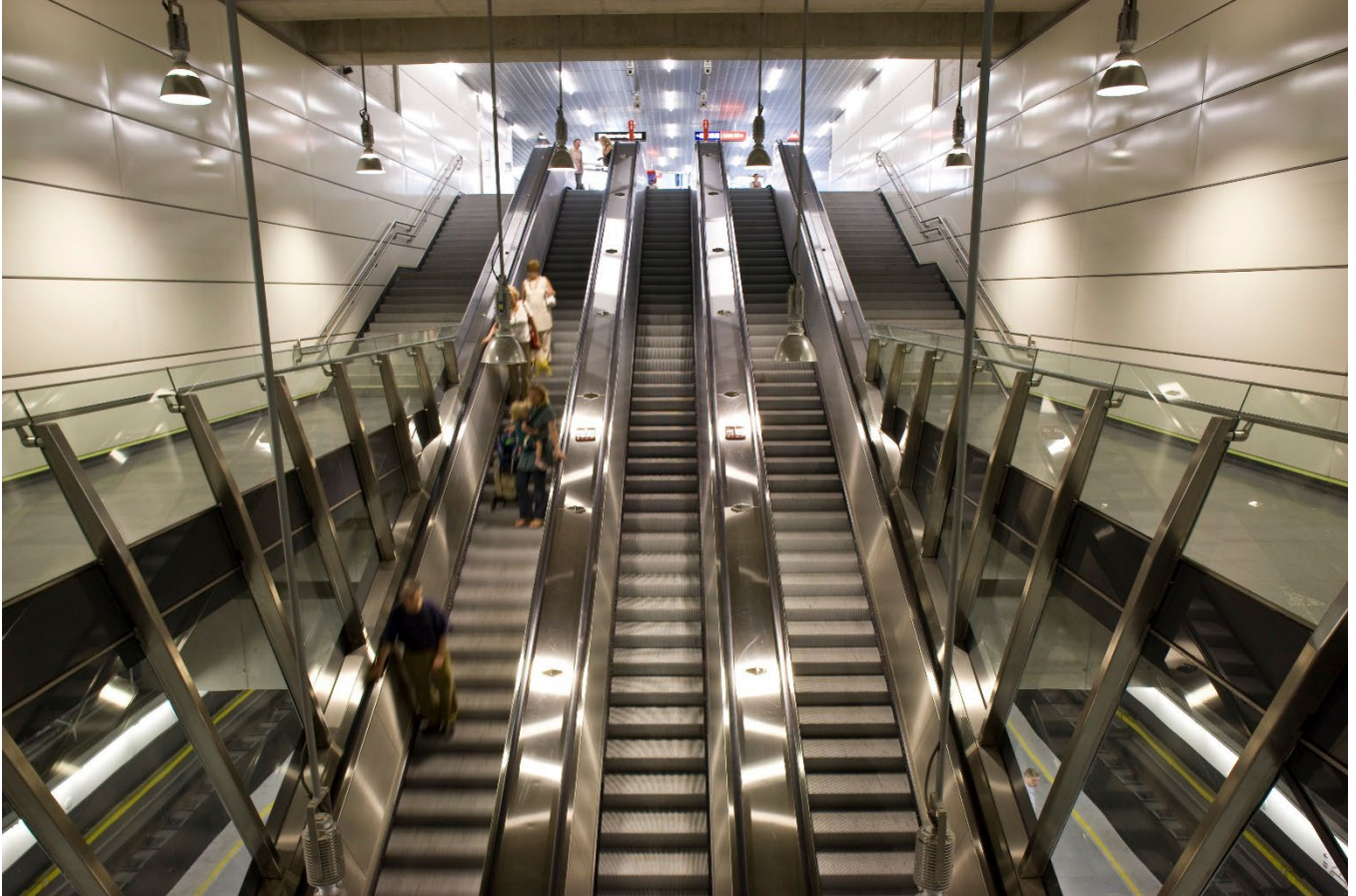
Zahlreiche Leuchten erhellen einen U-Bahnhof in Wien.
