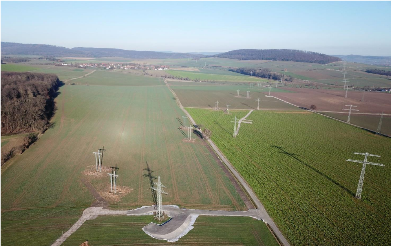
Errichtung der Höchstspannungsleitung Wahle-Mecklar inklusive Provisorien und Zufahrtswegen.
