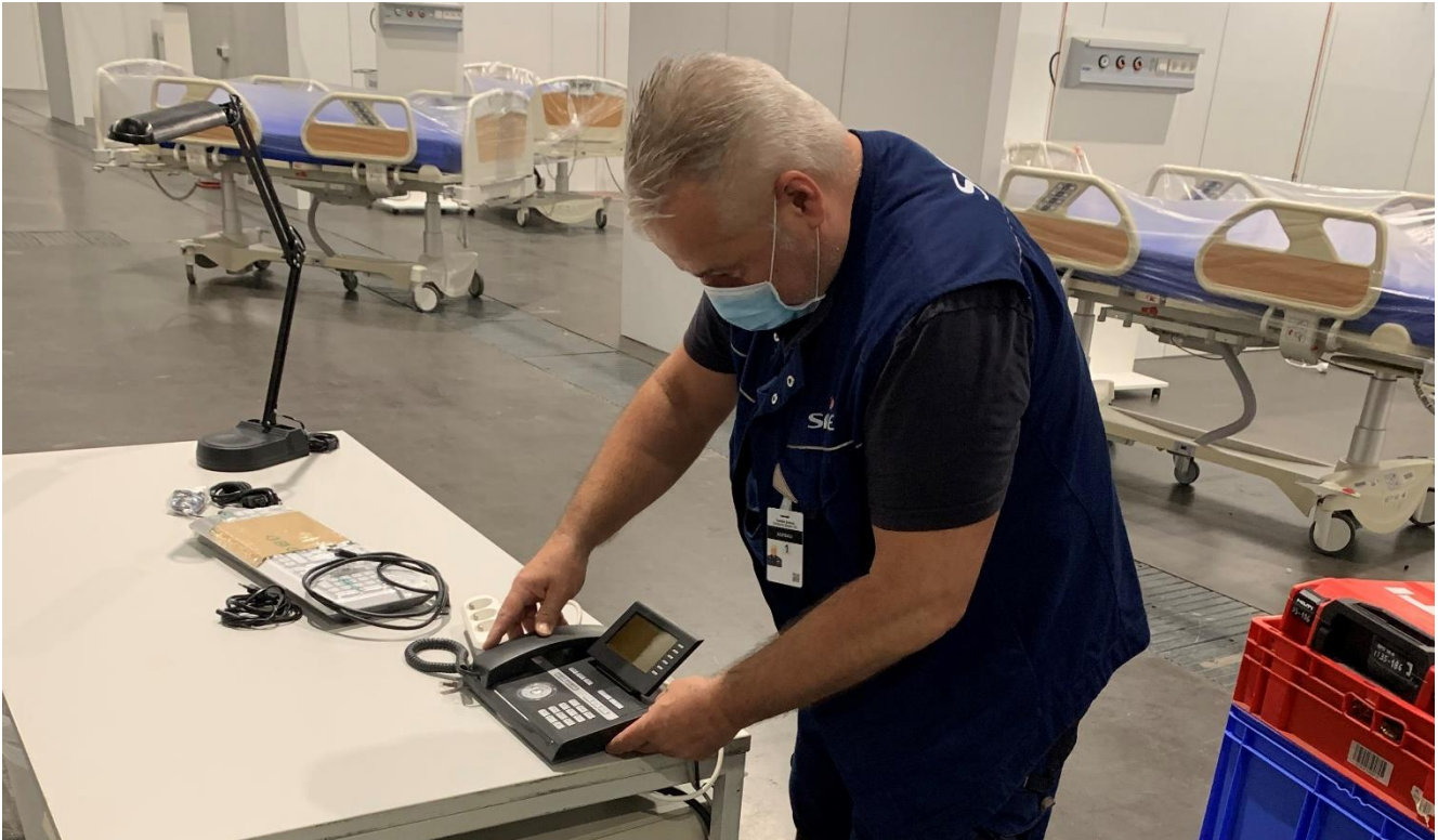
SPIE Techniker installiert Telekommunikationsanlage im Behelfskrankenhaus
